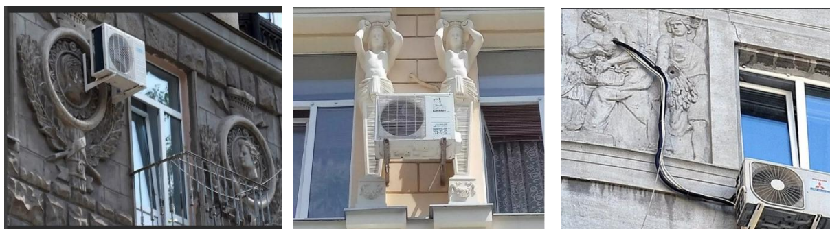
Рисунок 2 – Установка внешнего блока кондиционера на фасаде здания
