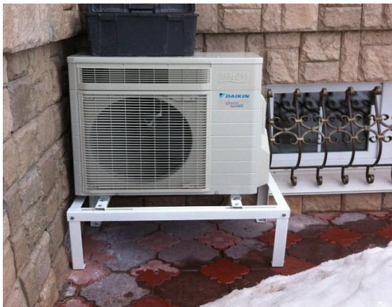
Рисунок 6 –Установка внешнего блока кондиционера
