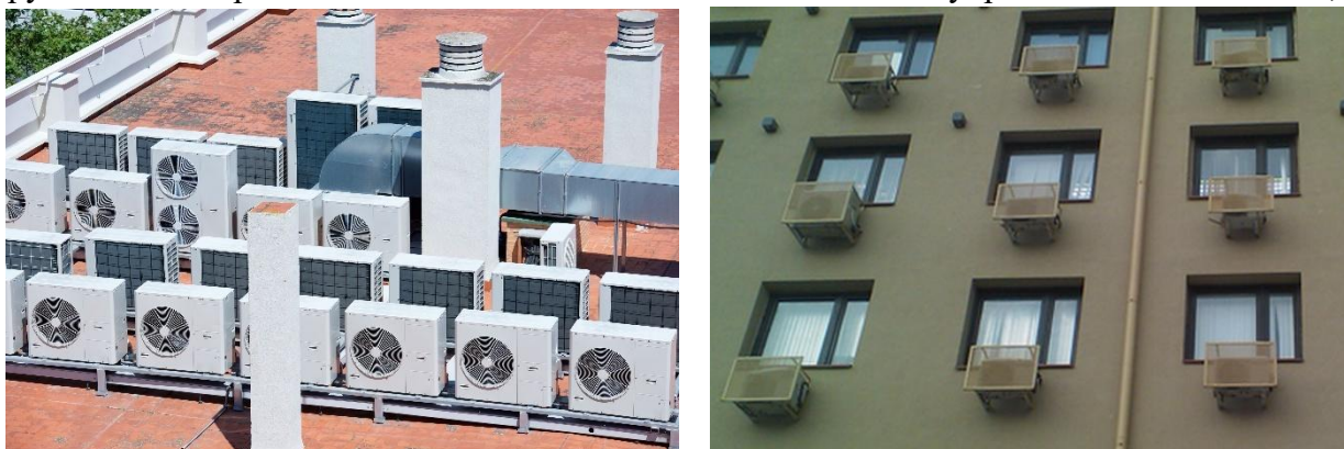
Рисунок 4 – Установка внешних блоков на крыше и задней части здания
