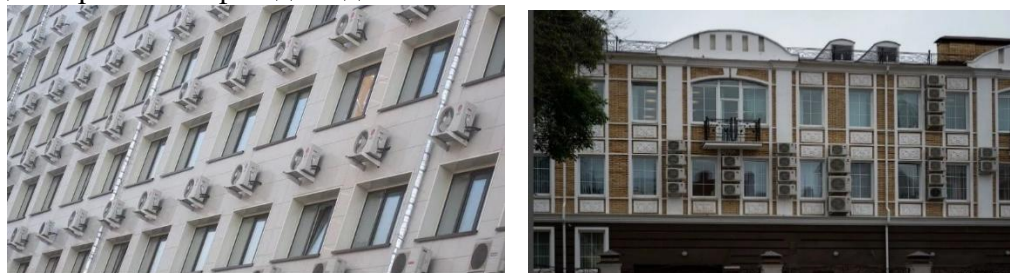
Рисунок 1 – Установка внешнего блока кондиционера
