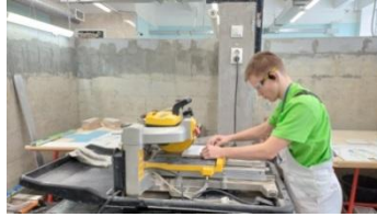
Рисунок 3 – Резка плитки на станке DEWALT DWC410
