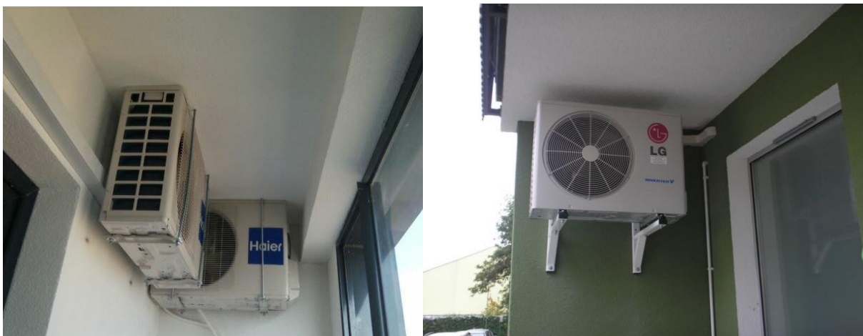
Рисунок 3 – Размещение наружного блока кондиционера на балконе
